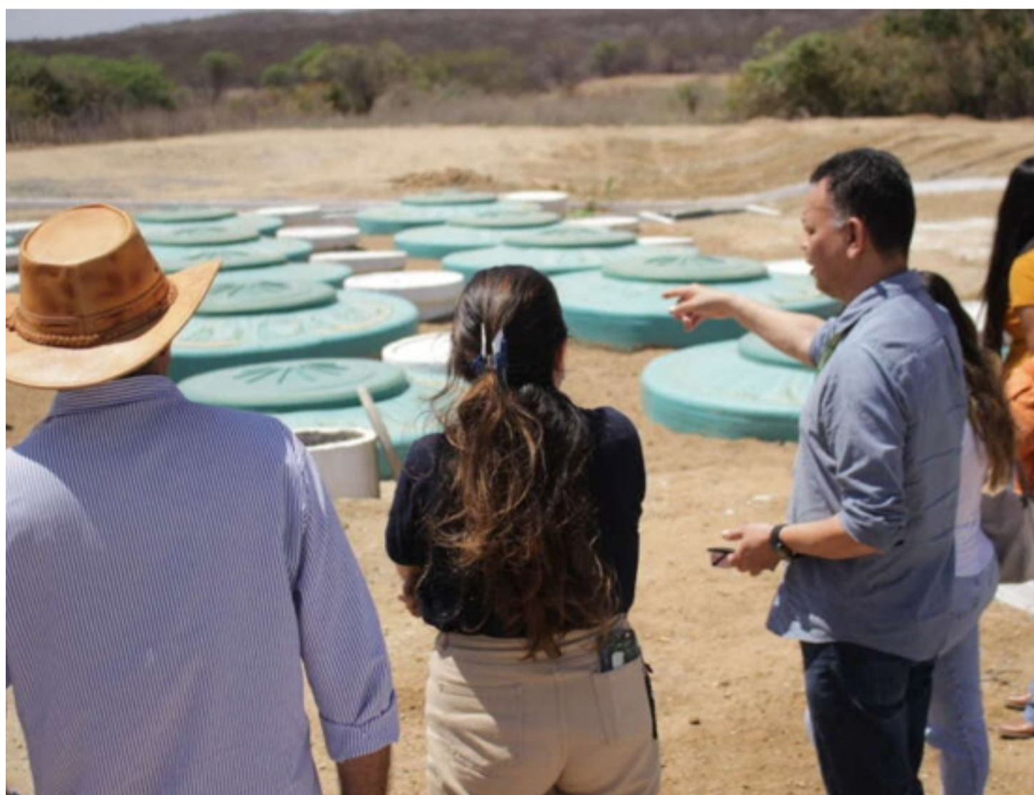
A implantação do sistema de saneamento está em fase de conclusão - Foto: Divulgação
